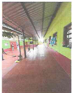
Foto 5: Instalación de piso cerámico en corredor de 24.13 metros x 3.10 metros piso sobre piso.
