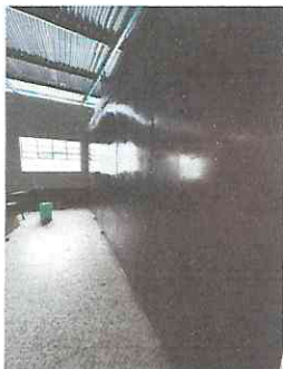
Foto 3: Reparación de división de metal existente, entre aulas sexto B y sexto A.
