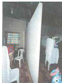
Foto 6: Construcción de cubículo en dirección.
